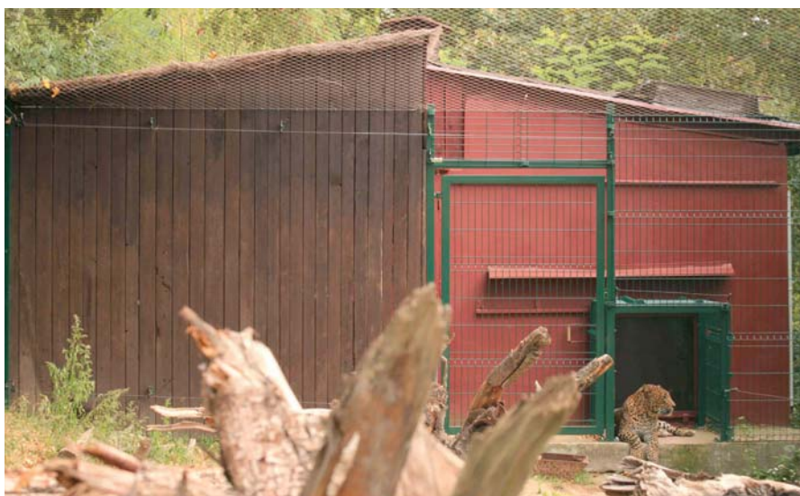
Ubikace v novém výběhu levhartů cejlonských vznikla adaptací staršího objektu / The facility of the leopards was made by rebuilding an older object
